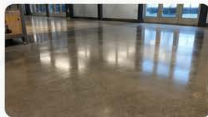
Primer Applied Surface
